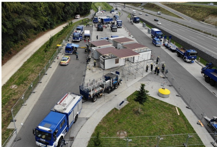
Aufbau der Corona-Teststation auf dem Parkplatz Kemptal-Ost Bild: THW
