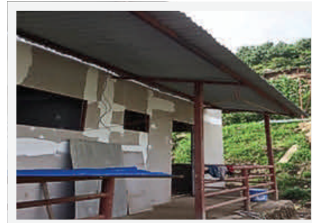
Gesundheitsposten Bhalche während des Baus Bildnachweis: RSDC/Malteser International
