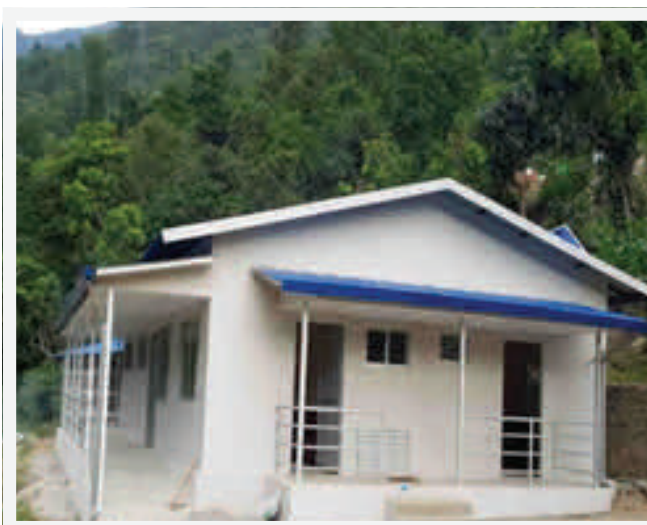
Pagretar Gesundheitsposten nach der Fertigstellung Bildnachweis: Malteser International
