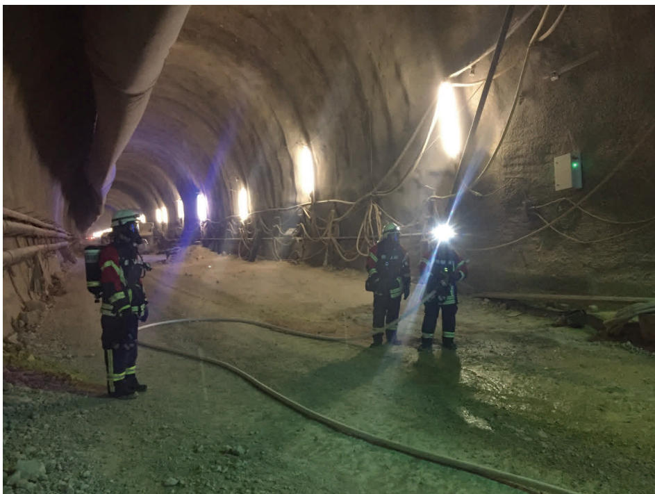
Ein Feuerwehrtrupp steht in einer Tunnelröhre für die Brandbekämpfung bereit
